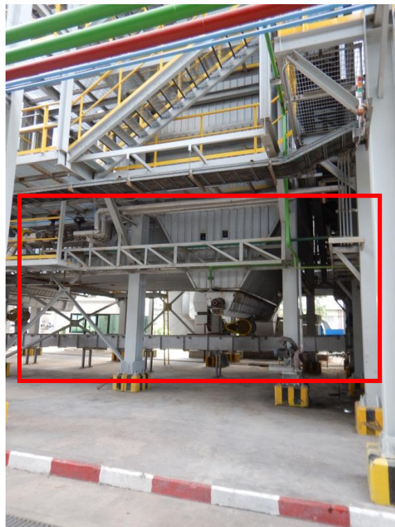
รูปที่ 2.70 ระบบลำเลียงซี้ไถ้ล่อย (Fly ash)
