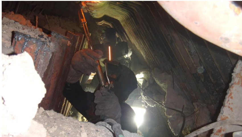
รูปที่ 10.62 การตรวจสอบแก้ไขท่อ Water Wall Upper Header
