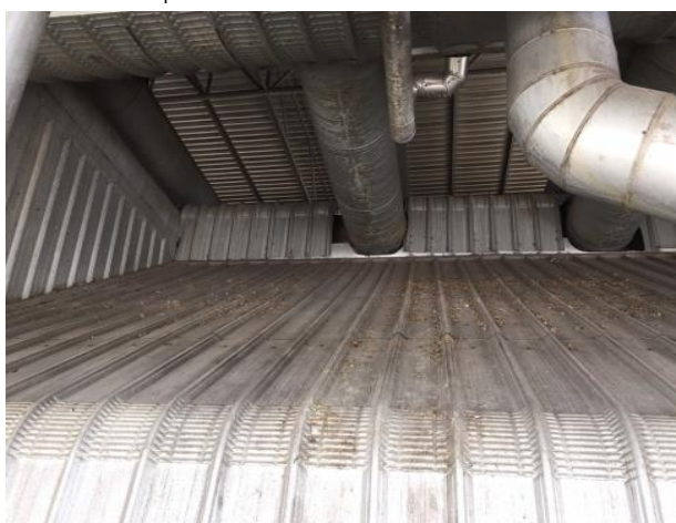
(ก) ผนังด้านบนหม้อน้ำ
