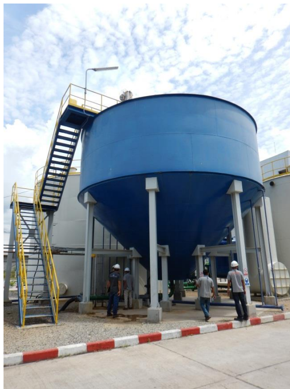
รูปที่ 2.19 ถังตกตะกอน (Clarifier tank)
