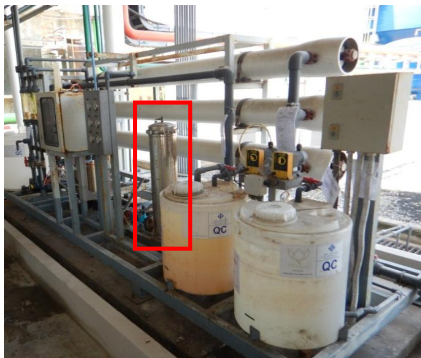
รูปที่ 2.26 ไส้กรองขนาด 5 Micron (Micro filter column)
