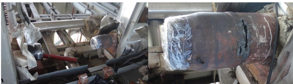
รูปที่ 10.39 สภาพการตัด Main Steam Valve และแนวการตัดท่อ Steam Piping
