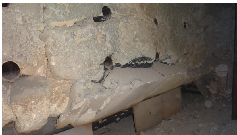
รูปที่ 10.23 สภาพปูนทนไฟมีการแตกร้าวรอบผนังห้องเผาไหม้ และแผ่นกั้นเชื้อเพลิงย้อนกลับชำรุด
