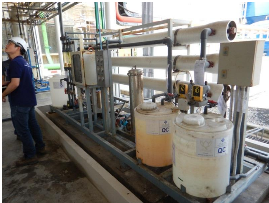
รูปที่ 2.27 ระบบรีเวอร์สออสโมซิส RO (Reverse osmosis membrane)
