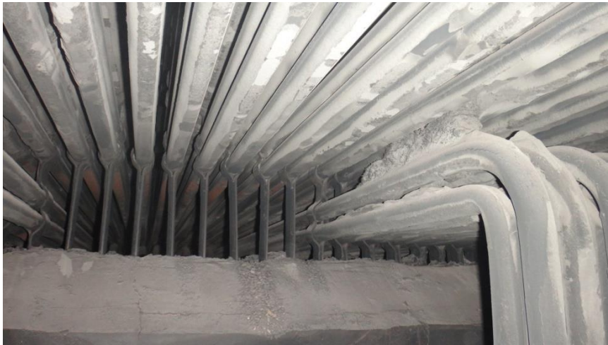
รูปที่ 10.69 สภาพ Tube Support ของท่อ Economizer Tube
