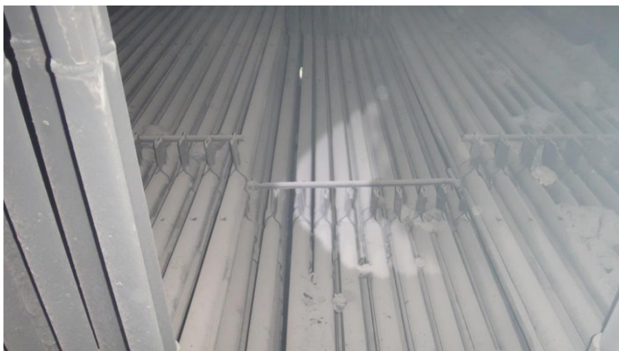
รูปที่ 10.68 สภาพท่อ Economizer Tube
