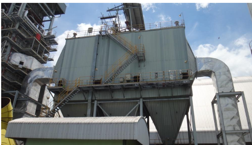
รูปที่ 10.47 Electro Static Precipitator (ESP)
