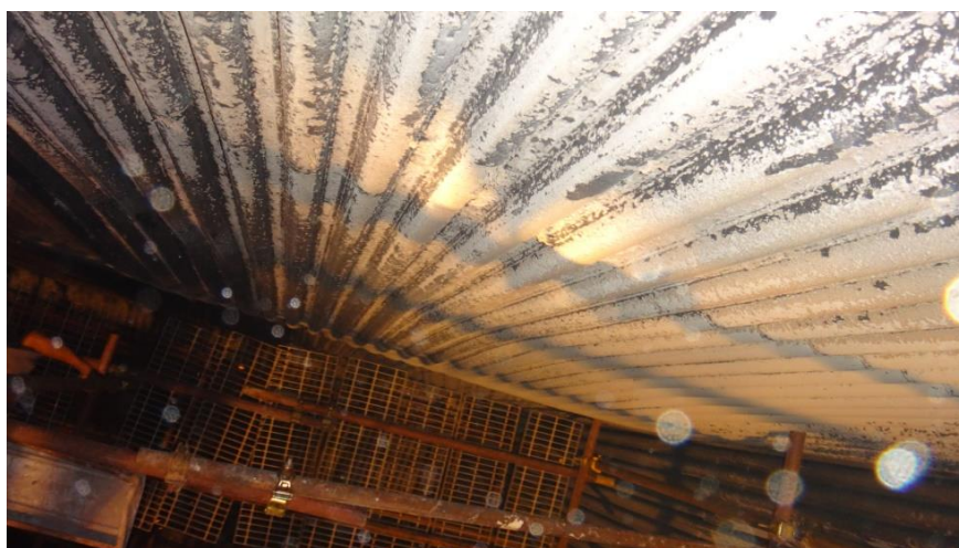
รูปที่ 10.61 สภาพท่อ Water wall Tube ที่เกิดการโก่งตัว
