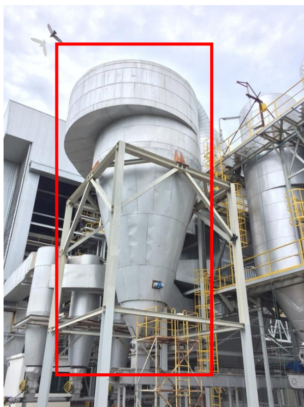
รูปที่ 2.68 ชุดดักฝุ่นไถ่ไอเสียระบบไซโคลน (Dust-Collector) ก่อนเข้า Bag filter
