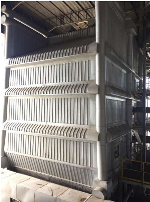
รูปที่ 2.50 หม้อน้ำชนิดท่อน้ำ (water tube boiler)
