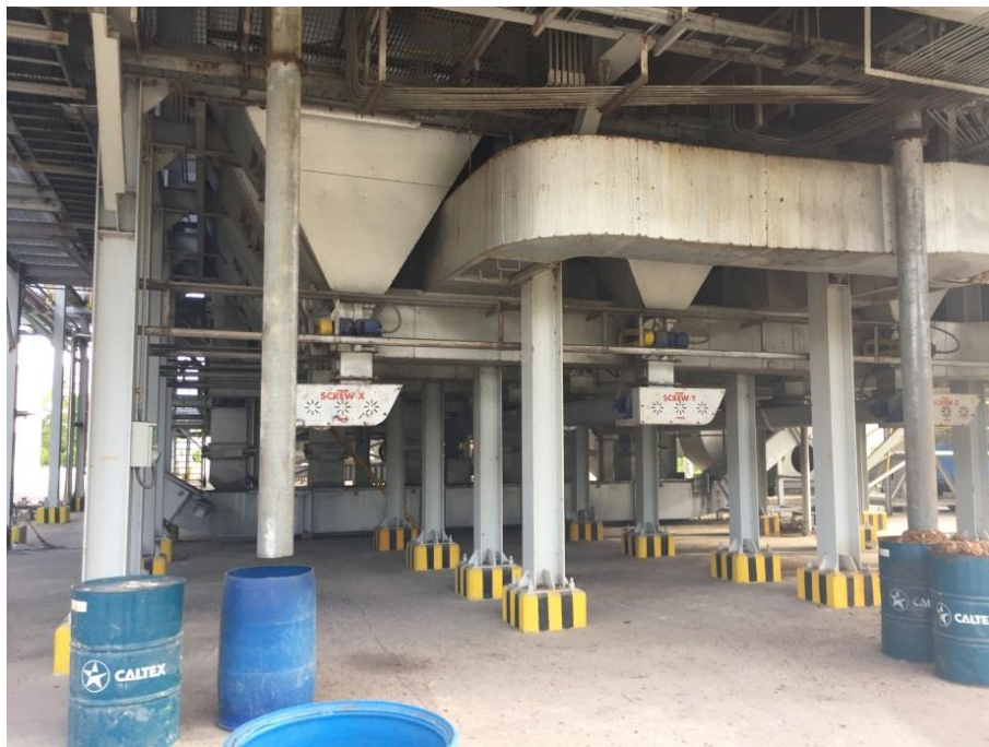
รูปที่ 2.66 ระบบลำเลียงขี้เถ้าหนัก (Bottom ash)
