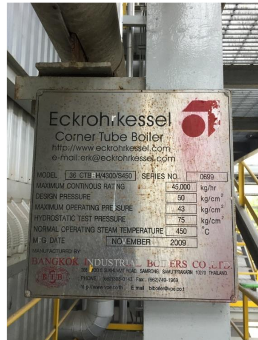
รูปที่ 2.50 หม้อน้ำชนิดท่อน้ำ (water tube boiler)
