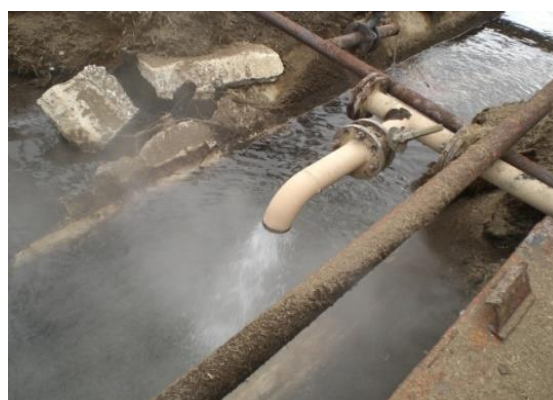
รูปที่ 9.79 น้ำคอนเดนเสทถูกปล่อยทิ้งจากชุด PRDS 60 ตัน
