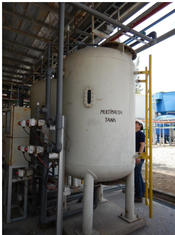
รูปที่ 2.23 ถังกรองผ่านชั้นหิน และทราย (Multimedia filter column)
