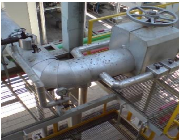
(ค) ท่อเมนสติก่อนเข้ากังหันไอน้ำ จุดที่ 2 (ง) ภาพถ่ายความร้อนท่อเมนสติก่อนเข้ากังหันไอน้ำ
