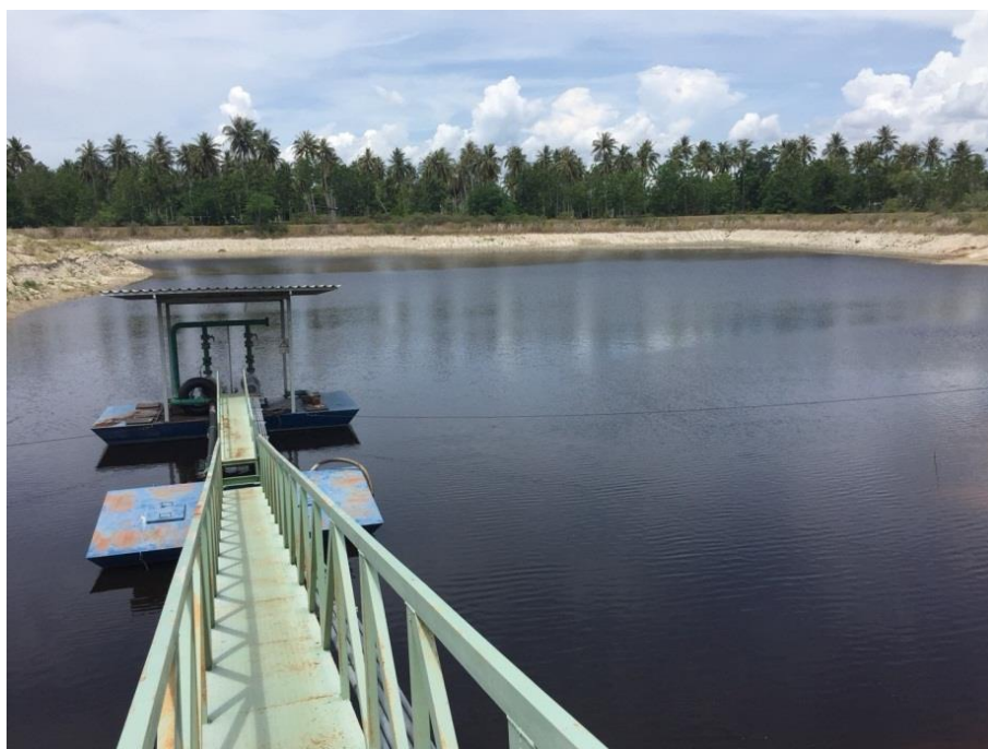
รูปที่ 2.16 บ่อน้ำดิบของโรงไฟฟ้า
