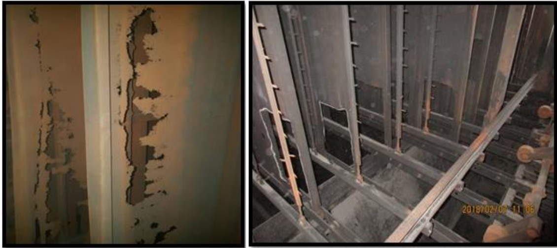
รูปที่ 10.48 Collecting Plate และ Discharge Electrode มีการผุกร่อน
