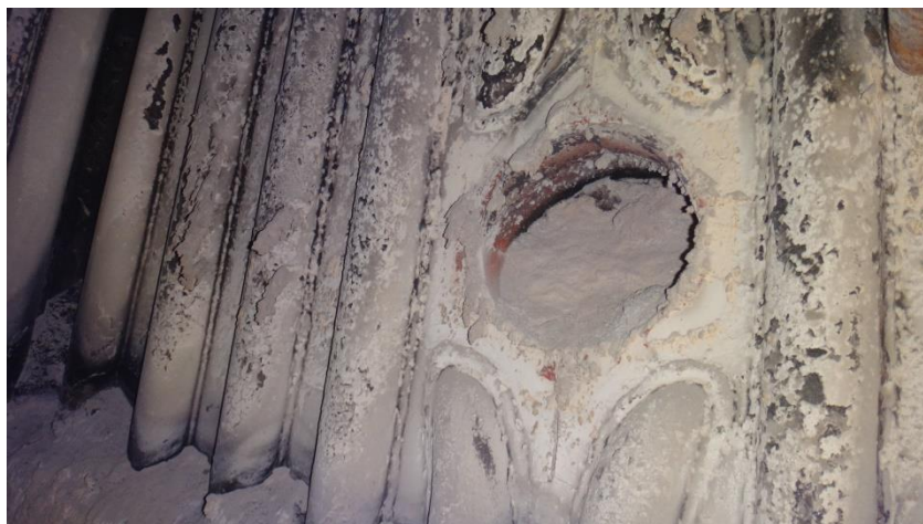
รูปที่ 10.25 สภาพเก่าที่อุดตันบริเวณช่องท่อลม Secondary Air
