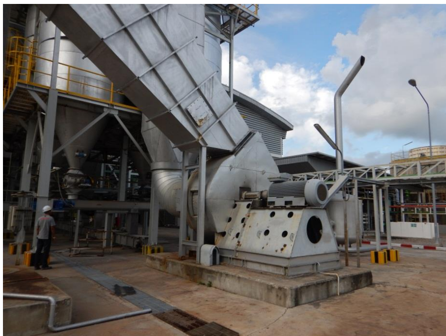
รูปที่ 2.56 พัดลมดูด (Inducted Draft Fan)
