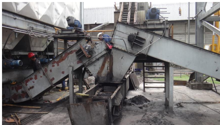
รูปที่ 10.33 Common Ash Chain Conveyor ของระบบ Ash Handling System
