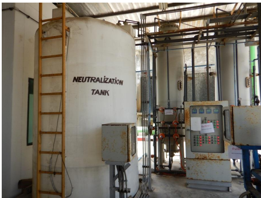
รูปที่ 2.29 ระบบผลิตน้ำปราศจากอิออน (Demineralized water)
