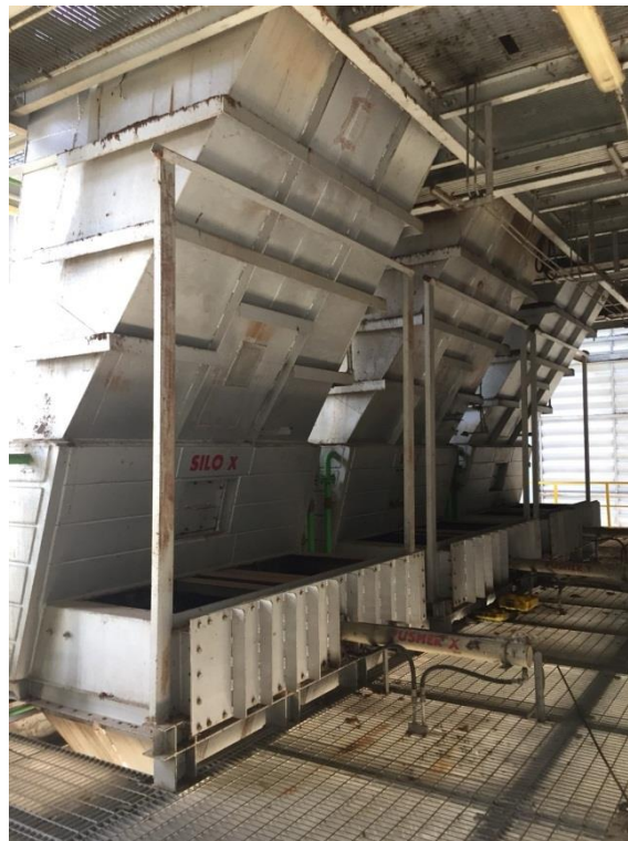
รูปที่ 2.46 ชุดป้อนเชื้อเพลิงเข้าหม้อน้ำแบบ Pusher 3 ชุดป้อน
