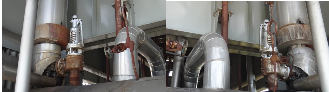
รูปที่ 10.40 Drum Safety Valve
