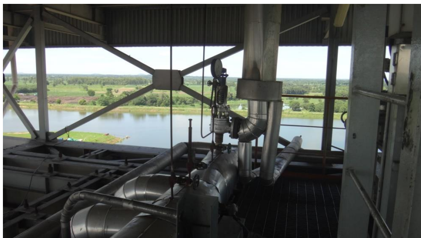
รูปที่ 10.41 Superheater Safety Valve
