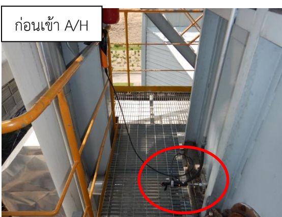
รูปที่ 4.15 การติดตั้งเครื่องวัดก๊าซไอเสียของหม้อน้ำ
