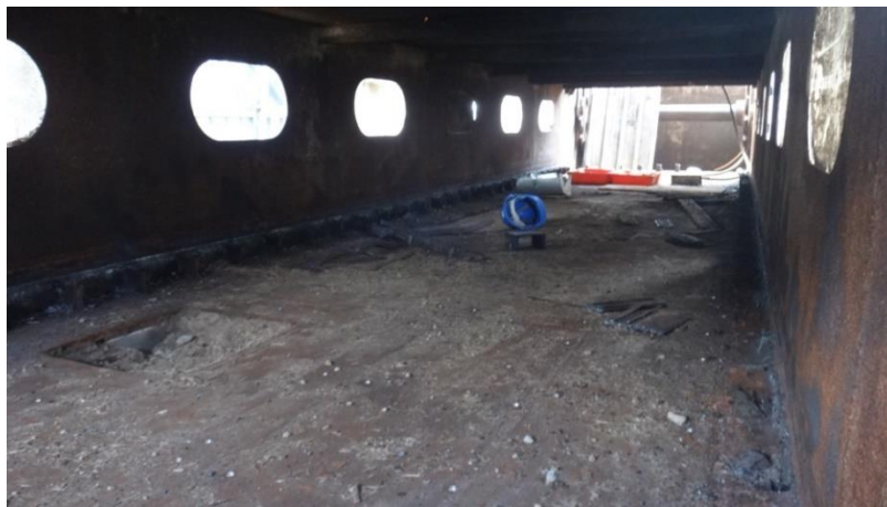
รูปที่ 10.19 การตรวจสอบและแก้ไข Fuel Chain Conveyor
