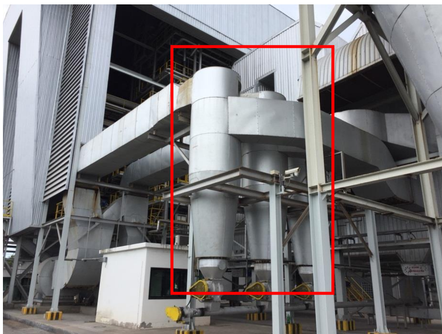
รูปที่ 2.67 ชุดดักฝุ่นไถ่ไอเสียระบบไซโคลน (Dust-Collector) ก่อนดูดกลับไปเป่าในห้องเผาไหม้(RFG)
