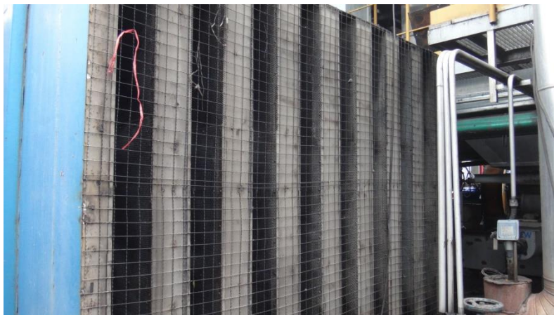
รูปที่ 10.43 Suction Strainer ของ FD. Fan
