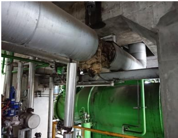
(ก) ท่อเมนสติก่อนเข้ากังหันไอน้ำ จุดที่ 1 (ข) ภาพถ่ายความร้อนท่อเมนสติก่อนเข้ากังหันไอน้ำ
