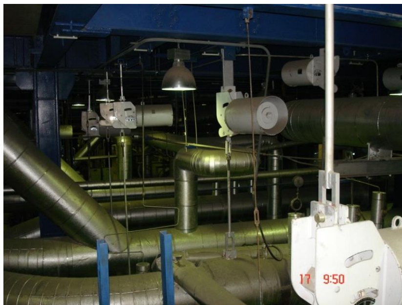
รูปที่ 10.6 Pipe Support แบบ Spring Hanger
