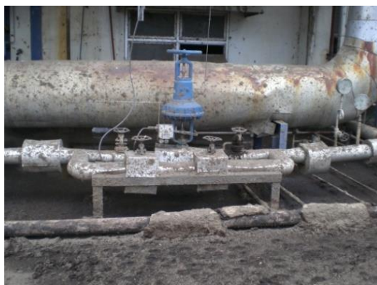
รูปที่ 9.79 น้ำคอนเดนเสทถูกปล่อยทิ้งจากชุด PRDS 60 ตัน
