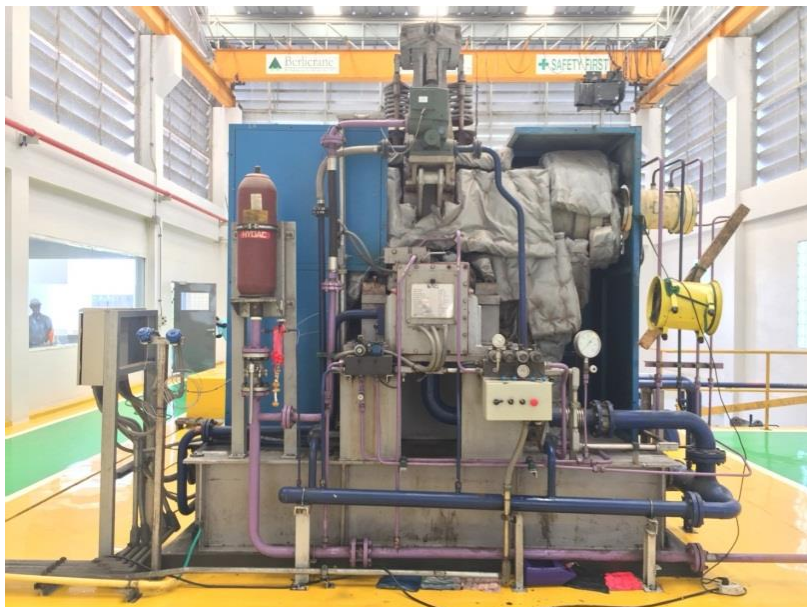
รูปที่ 6.28 กังหันไอน้ำแบบ Extraction condensing turbine
