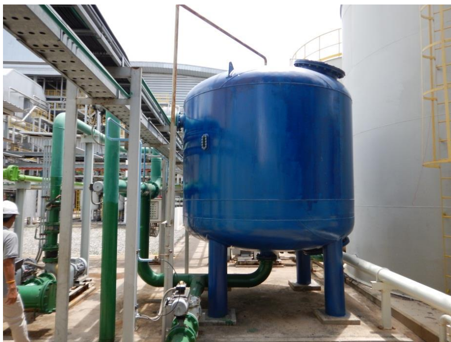
รูปที่ 2.21 ถังกรองทราย (Sand filter column)
