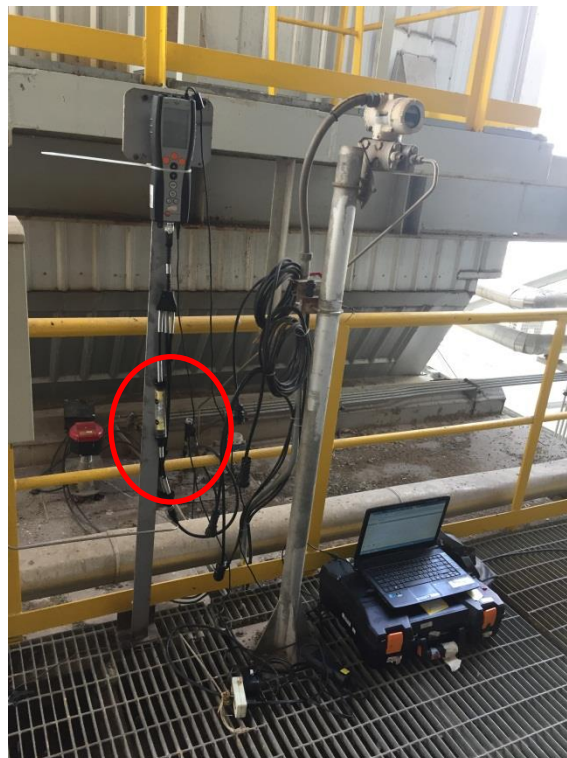
รูปที่ 9.4 การติดตั้งเครื่องวัดก๊าซไอเสียของหม้อน้ำในตำแหน่งก่อนเข้า Economizer
