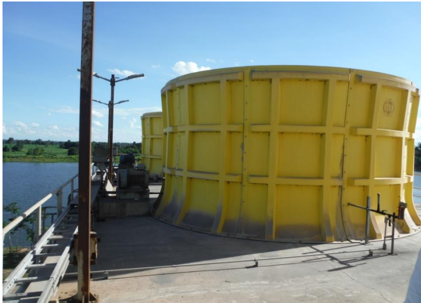
รูปที่ 10.54 ชุด Motor Drive ของ Cooling Tower Fan
