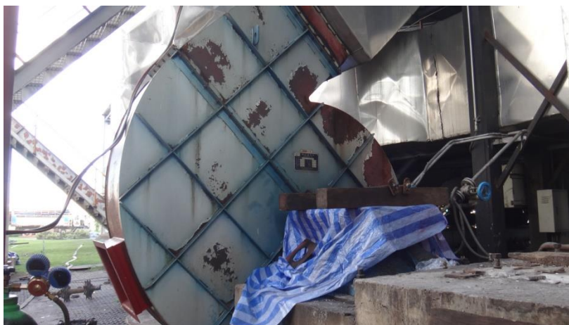
รูปที่ 10.44 Secondary Air Fan (SA. Fan)
