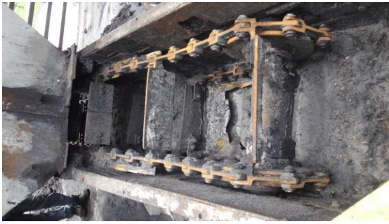
รูปที่ 10.35 Common Ash Chain Conveyor ของระบบ Ash Handling System
