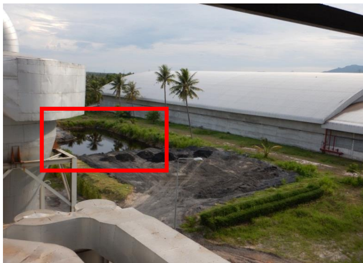
รูปที่ 2.36 บ่อบำบัดน้ำเสีย
