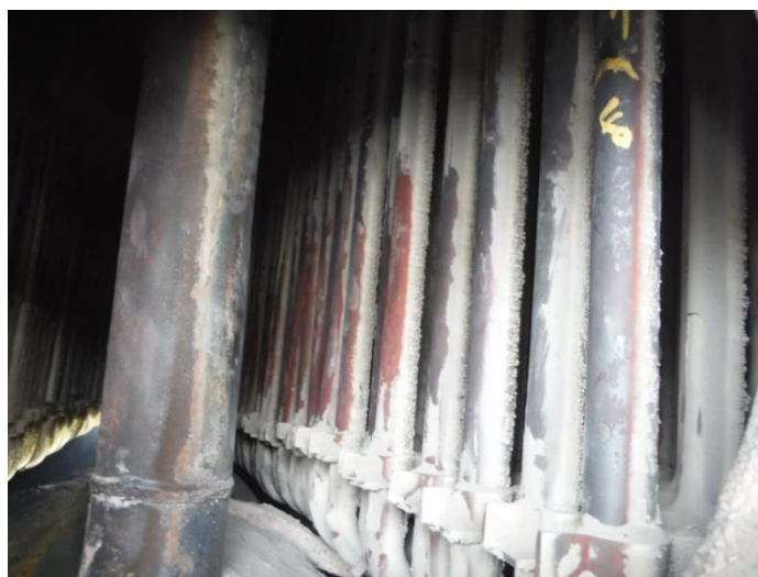
รูปที่ 10.64 สภาพท่อ High Temp. Superheater Tube
