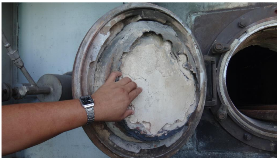
รูปที่ 10.13 ฝา Man Hole เกิดการ Deform และชำรุดเสียหาย
