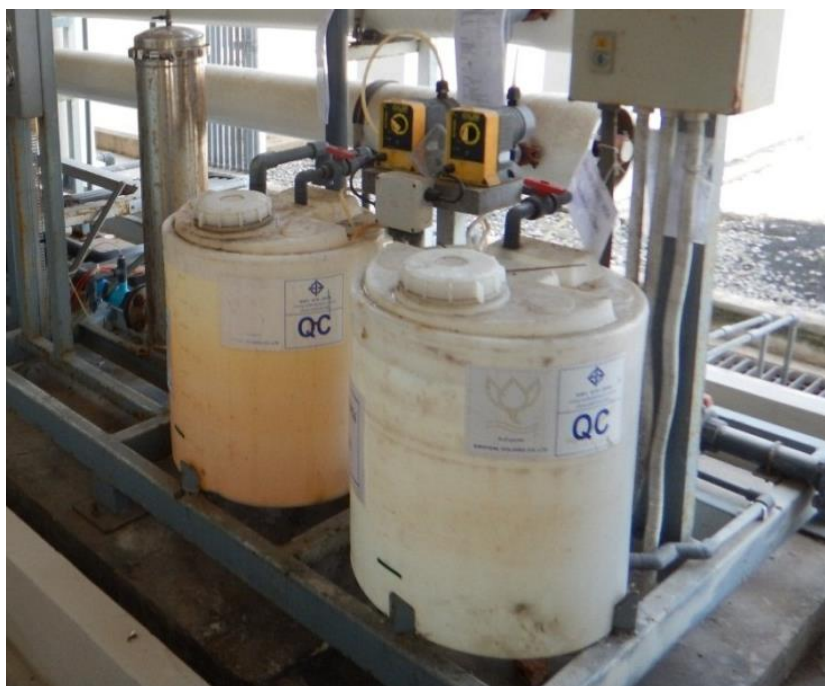
รูปที่ 2.25 ระบบเติมสารเคมีก่อนเข้าสู่ไส้กรองขนาด 5 Micron
