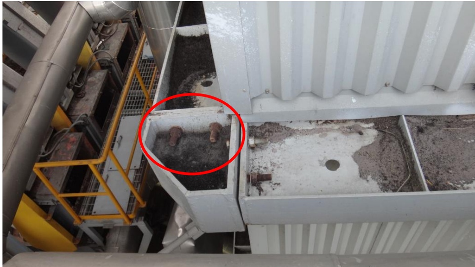
รูปที่ 10.10 Bolt ยึด Buck Stay คลายตัว
