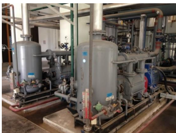
รูปที่ 9.77 ชุดปั๊มสุญญากาศของเครื่องควบแน่น
